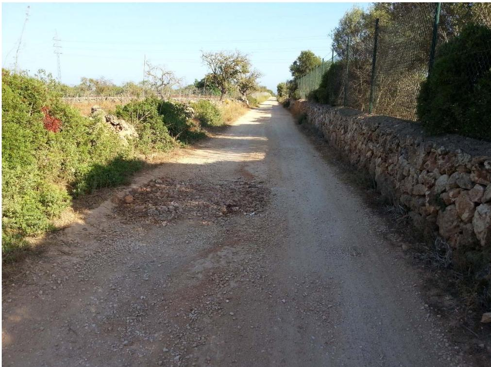
*Ilustración 5. Detalle: Bacheado con árido reciclado*
