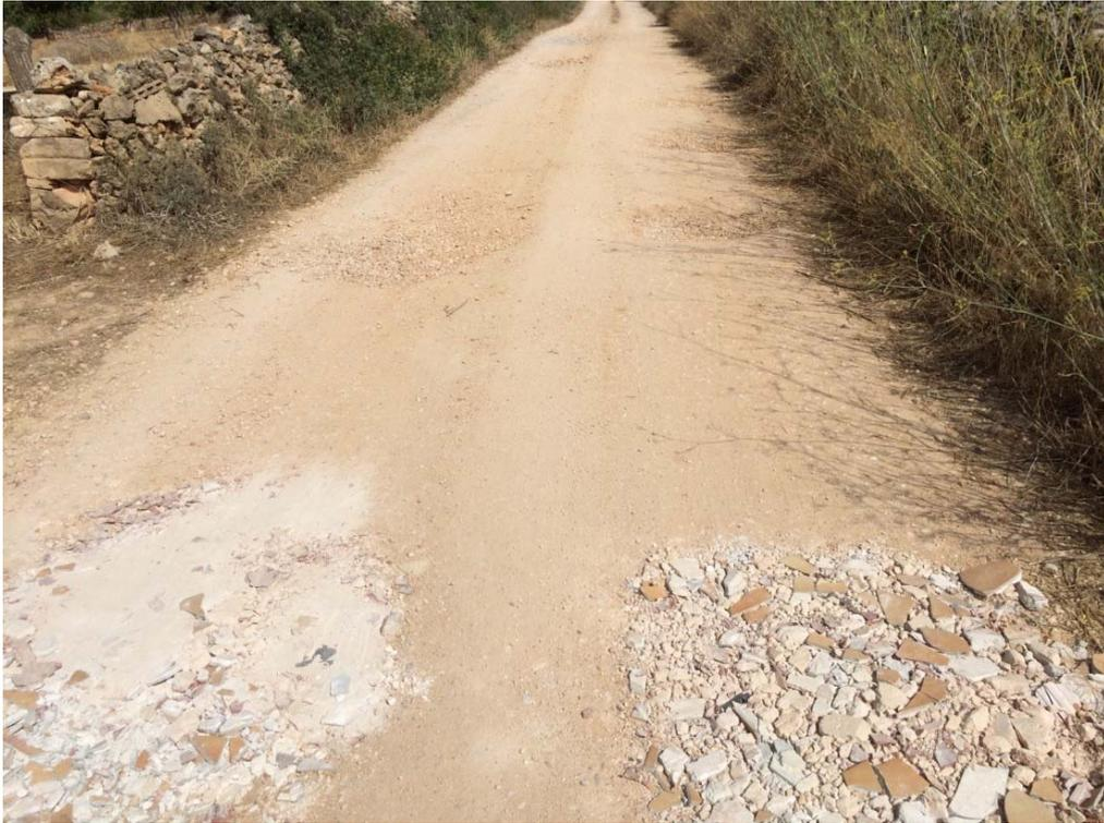
*Ilustración 6. Detalle: Bacheado con árido reciclado*
