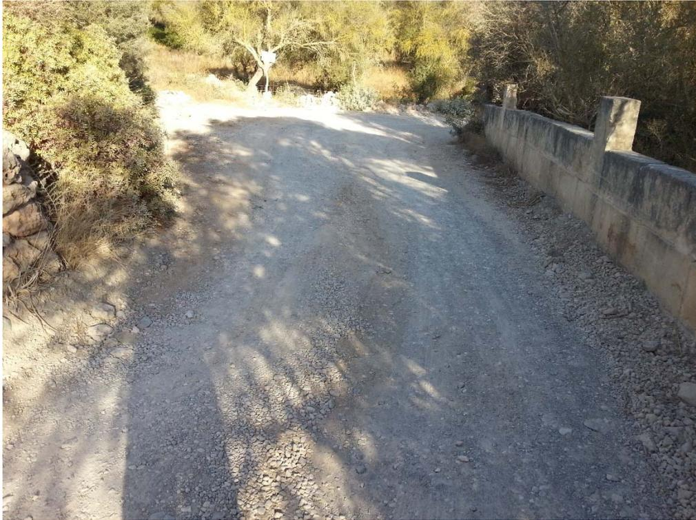
Ilustración 8. Detalle: Capa superficial del firme suelta (sin compactación)
