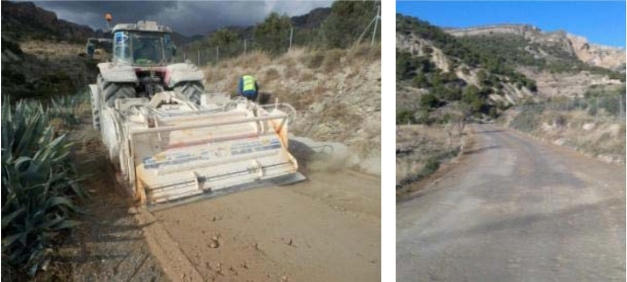
Fig. nº 6: Rehabilitación de camino rural mediante estabilización en Jijona (Alicante, 21013).
