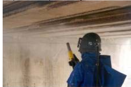
Preparación soporte: chorro de arena
