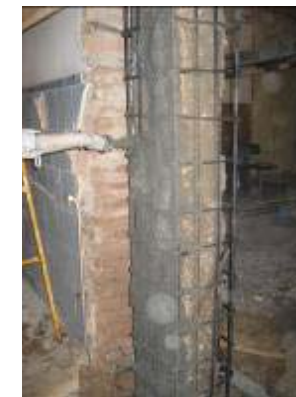
Proyección del mortero
