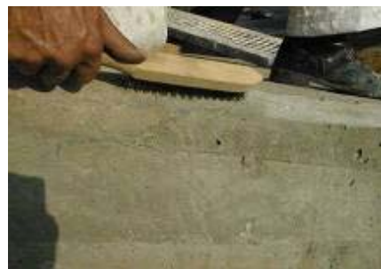
Preparación soporte: cepillado
