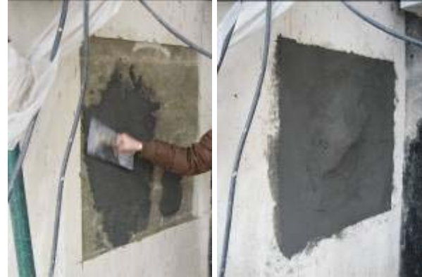
Aplicación de capa fina y a continuación se aplica el espesor necesario
