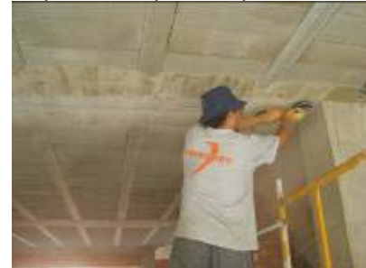
Preparación soporte: lijadora con disco de diamante
