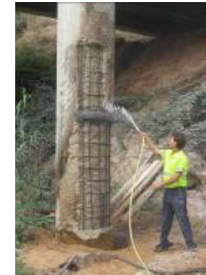
Hidratación del soporte a saturación
