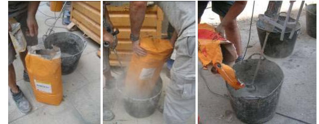
Mezclado con batidora de bajas revoluciones
