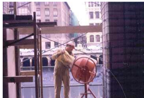
Aplicación mortero mediante la colocación de encofrado
