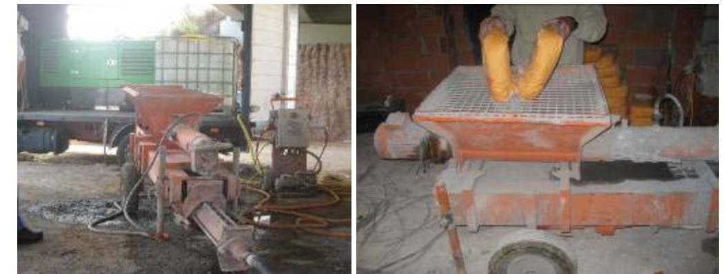
Aplicación mortero por proyección, mezclado en la propia máquina
