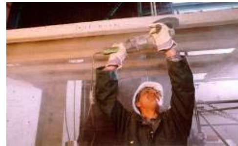
Preparación soporte: limpieza con radial
