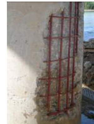
Sikadur® Primer EG (Phosphate) aplicado sobre las armaduras
